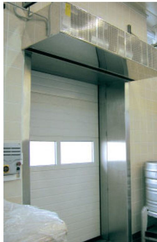
Posebna izvedba zračne zavese iz nerjavnega jekla
