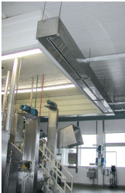
Posebna rešitev: napa z linijskimi difuzorji IMP Klime
