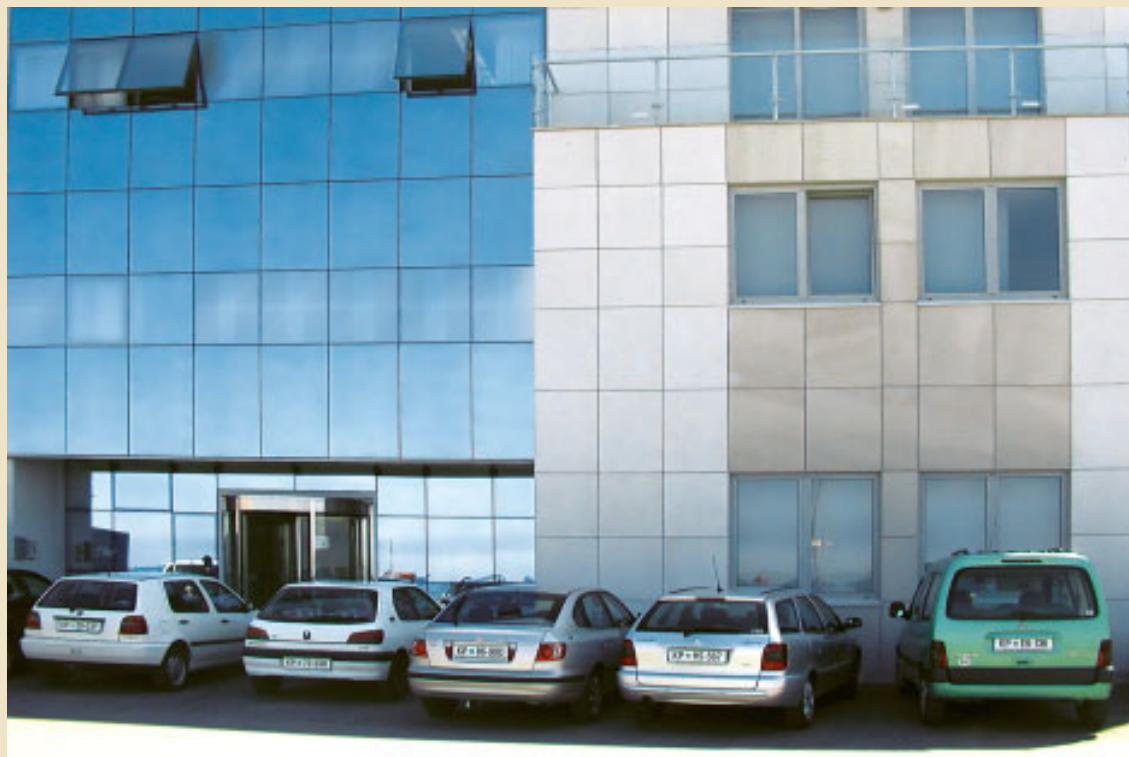
Prvi del sodobno urejene morske postaje; drugi del je še v gradnji.
