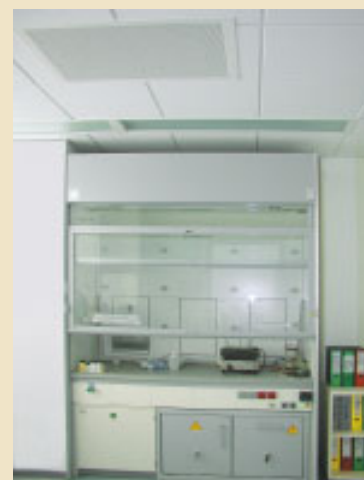
Prisilno prezračevani laboratoriji s filtrskimi enotami IMP Klima.
