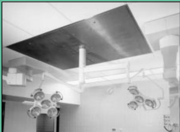
Operacijski strop za dovod čistega zraka
