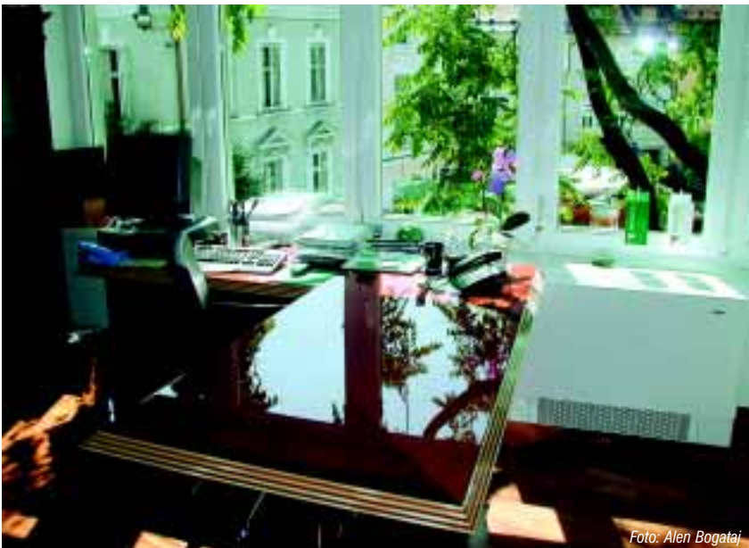
Rešitev z ventilatorskimi konvektorji
