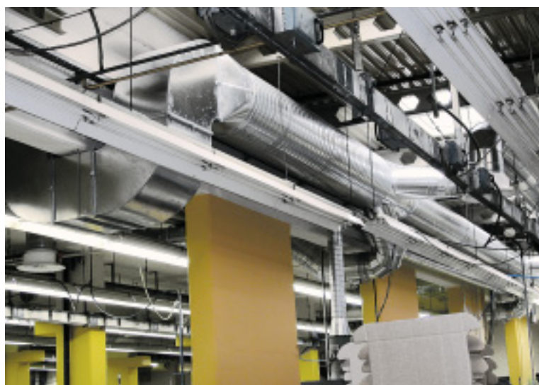
Razvod kanalov med vsemi obstoječimi inštalacijami.
