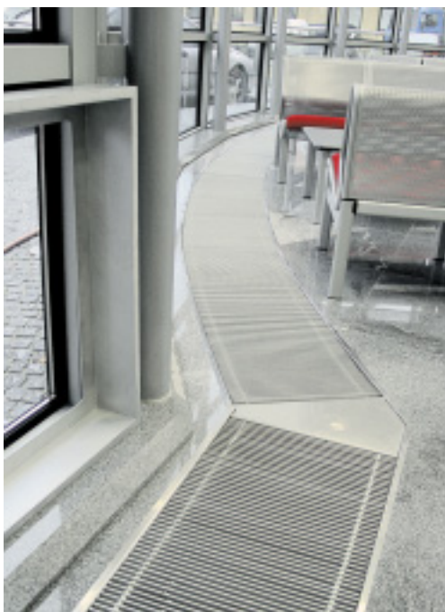
Primer usklajenega sodelovanja projektanta in dobavitelja - nepretrgana linija talnih konvektorjev, ki do potankosti sledi ukrivljenim konturam zunanje steklene fasade.
