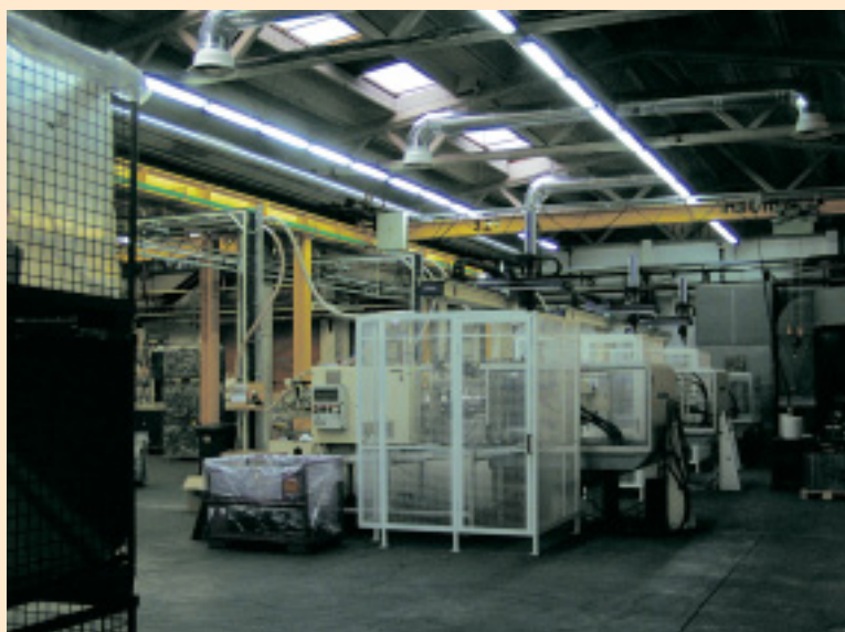
Slika 1: Distribucija zraka v obstoječi proizvodni hali.
