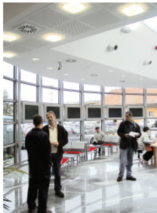
Nameščene šobe za preprečevanje rosenja v kupoli zagotavljajo velike dometne razdalje ob nizki šumnosti, hkrati pa so v interiorju oblikovno nemoteče.
