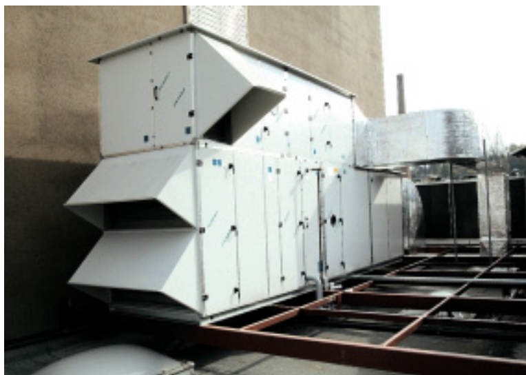
Postavitev klimata in hladilnega agregata.
