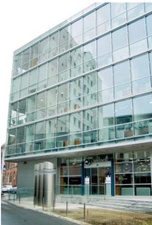
Upravna stavba Nove ljubljanske banke v Mariboru
